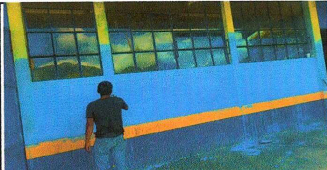
PINTANDO EXTERIOR E INTERIOR DEL CENTRO EDUCATIVO
