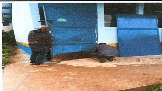
INSTALANDO LAS PUERTAS.
