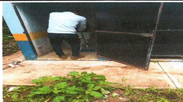
MEJORANDO LOS BAÑOS POR DETERIADOS
