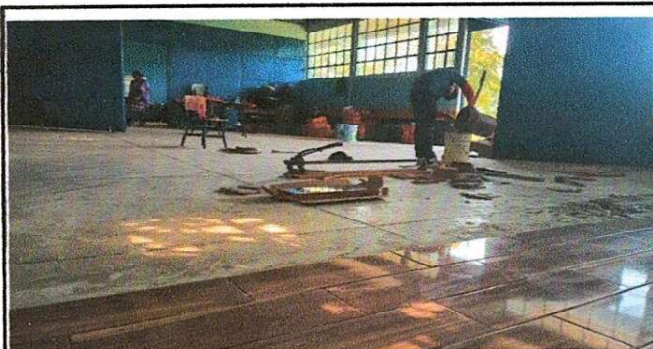
COLOCANDO PISOS EN AULAS
